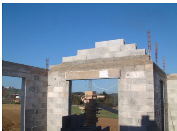
CONSTRUCTION PARASISMIQUE (© DDT65)
