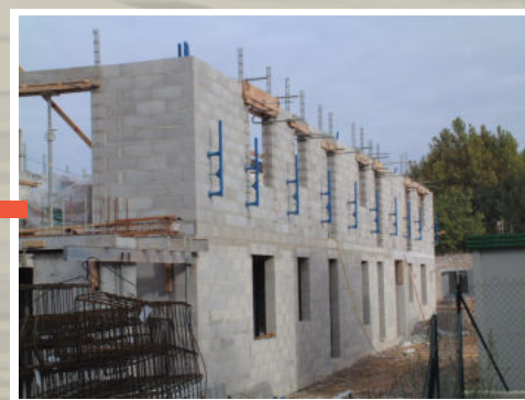
CONSTRUCTION PARASISMIQUE (© DDT65)
