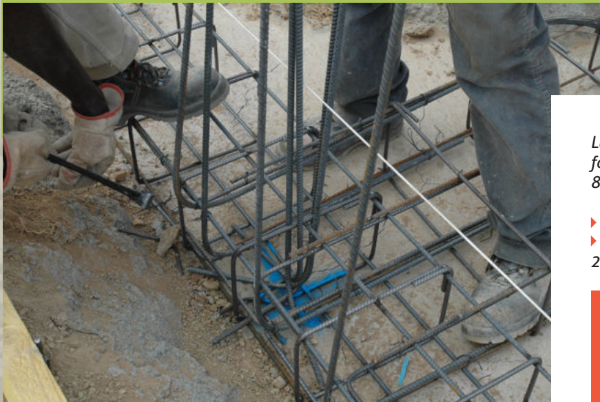
CHAINAGE ET LIAISON PARASISMIQUE (© DDT65)
