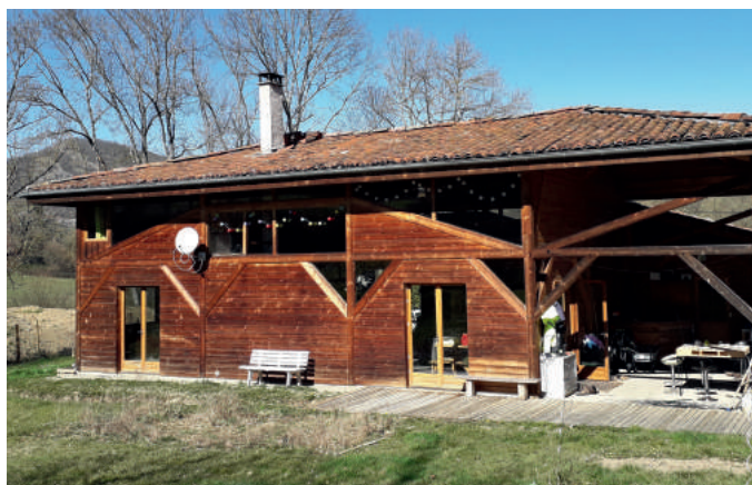
MAISON À OSSATURE BOIS (© DDT65)
